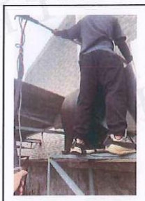
厨房油烟废气排放口
