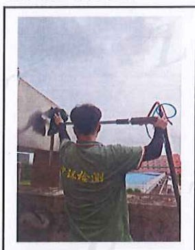
厨房油烟废气处理前
