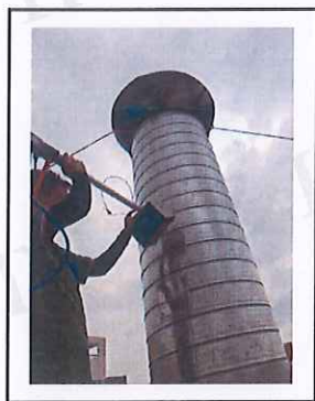
吸塑成型废气排放口
